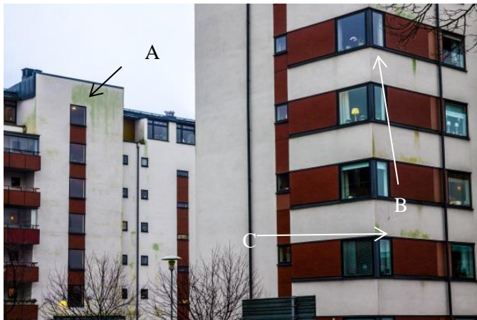
Figur 5 Exempel på hur fasadens utformning kan påverka vattenavrinning, risk för kondens och därmed påväxt av alger. Avsaknad av överhäng leder till att vattnet kan rinna fritt och att påväxt utvecklas (A). Under plåtarna (B) finns generellt inget sådant problem, däremot ovanför plåten (C) finns påväxt, vilket kan bero på stänk av vatten.
