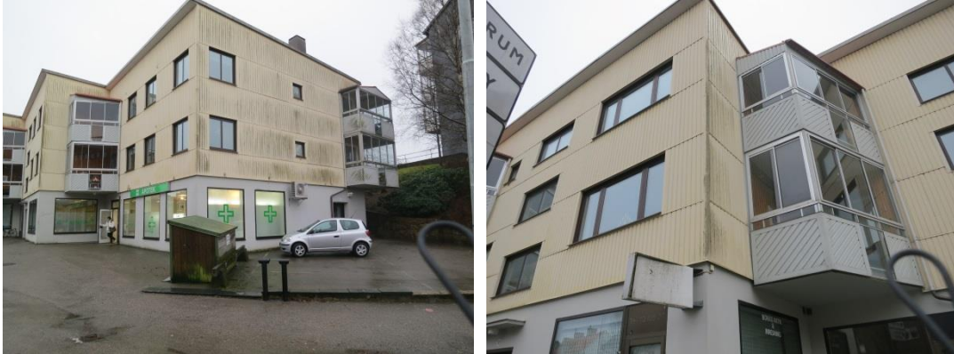
Figur 12 Byggnad med plåtfasad där det på fasaden åt norr finns kraftig missfärgande påväxt (mögelsvampar). Fasaden åt öst saknar sådan påväxt.
