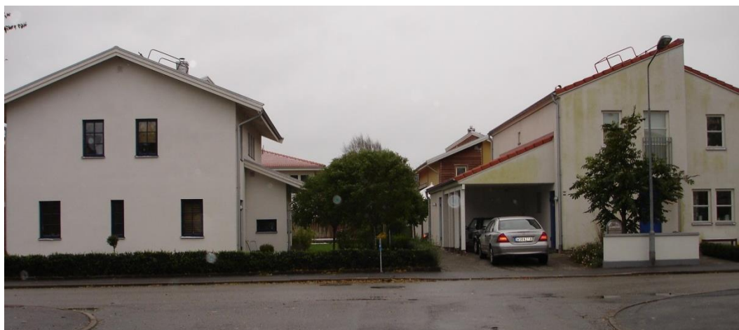
Figur 9 Två byggnader uppförda ungefär samtidigt (2 månaders skillnad). Huset till vänster är målat med färg innehållande zink oxid, vilket färgen i huset till höger saknar. Från (Johansson 2011).
