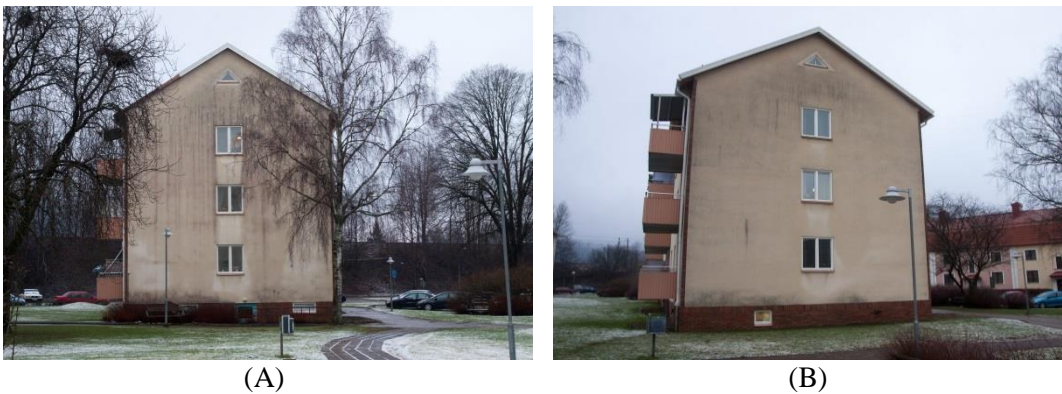
Figur 14 Fasader på två byggnader som ligger intill varandra. På fasad (A) finns betydligt större områden med missfärgningar än på fasad (B). I närheten till den första finns två stora träd.
