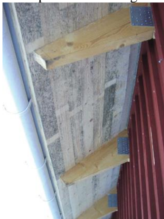
Figur 6 Typiska mönster på obehandlad råspont. Skillnaderna i missfärgande påväxt tros hänga med skillnader i näringsinnehåll.
