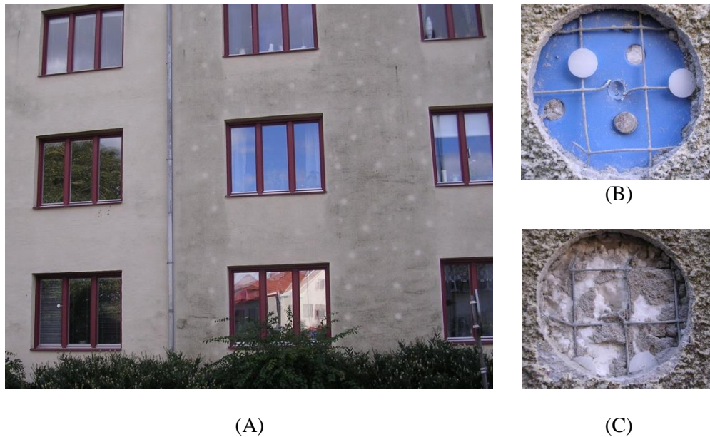
Figur 3 (A) En fasad med kraftig påväxt på, med undantag från ett antal cirkelformade områden. Under dessa finns fästelement av metall (B) som leder värme från den inre delen av väggen. Yttemperaturen är därför något högre här jämfört med övriga fasaden. Sådan infästning saknades under de områden där det påväxt saknades (C).
